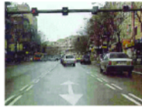
Marcas longitudinales discontinuas dobles
