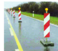
Luces amarillas fijas o intermitentes
